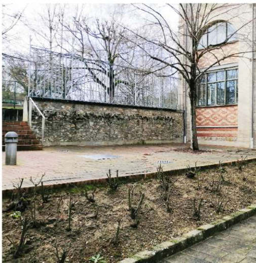
Avant : des escaliers
