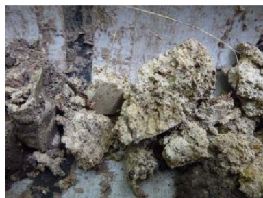
S07 : Détail du sondage
