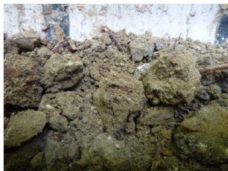
S08 : Détail du sondage
