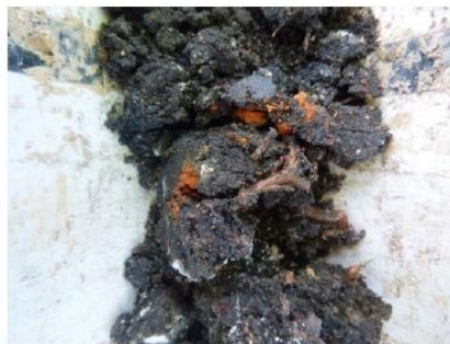
S06 : Détail du sondage
