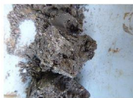
S01 : Détail du sondage
